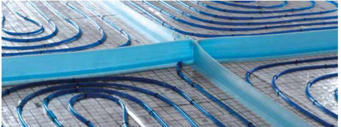
14. Ábra Fűtőmezők dilatációs hézagokkal való felosztása
