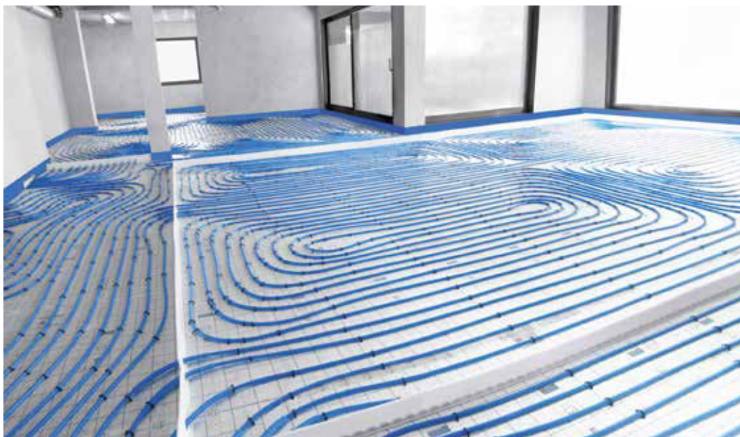
25. Ábra KAN-therm Tacker rendszer padlófűtés/-hűtés.
